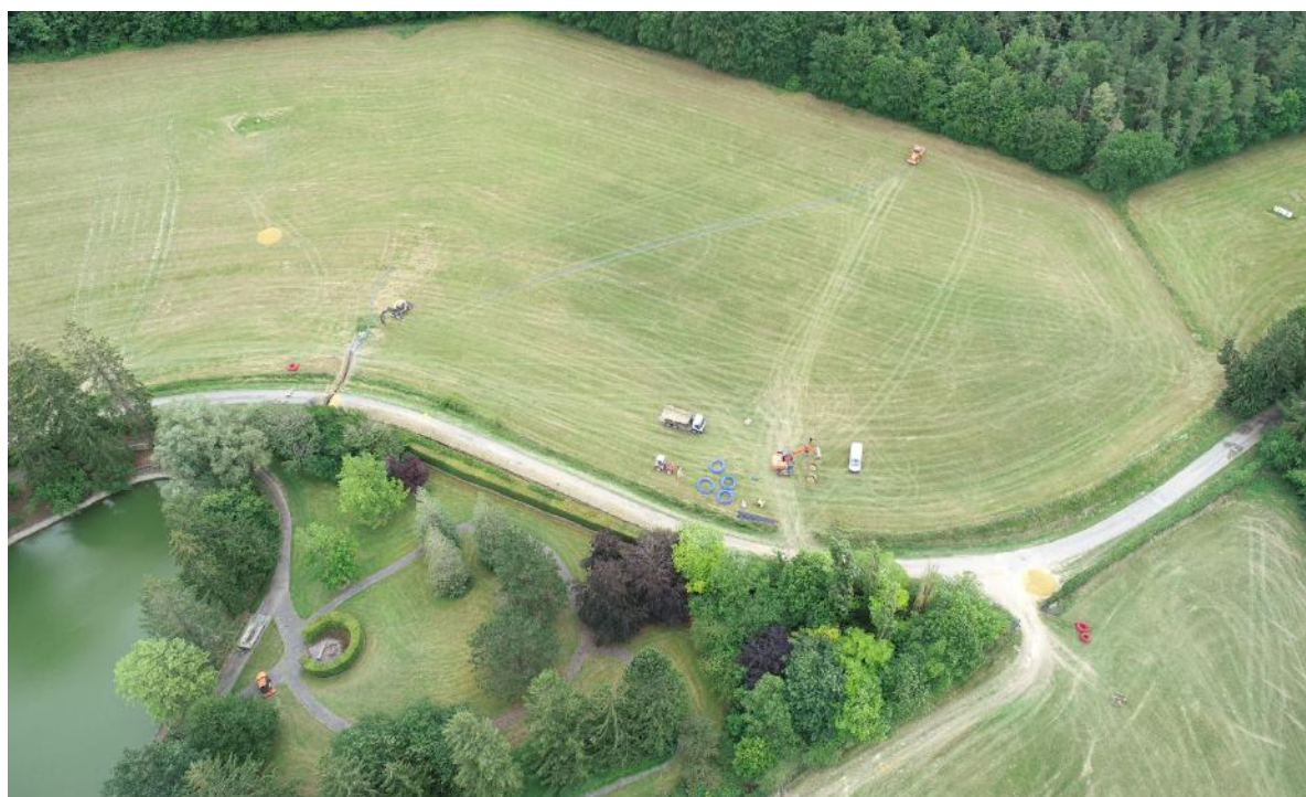
Installation des tranchées pour les puits F5 et F6
